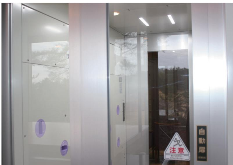
エアシャワーは人や搬入物の表面に付着した塵埃等の粒子を清浄化された高速エアージェットにより除塵します。またパスルームとしての効果もあり、外部とクリーンルームとの空気の流れを遮断し、汚染粒子の流入を防ぎます。
